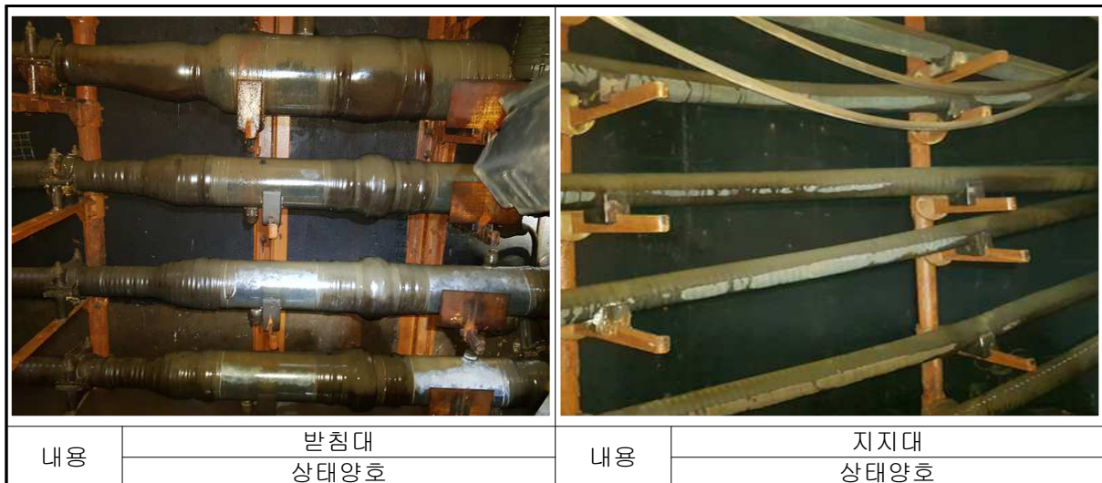
【사진 14.12】 부속 및 부대설비 현황
