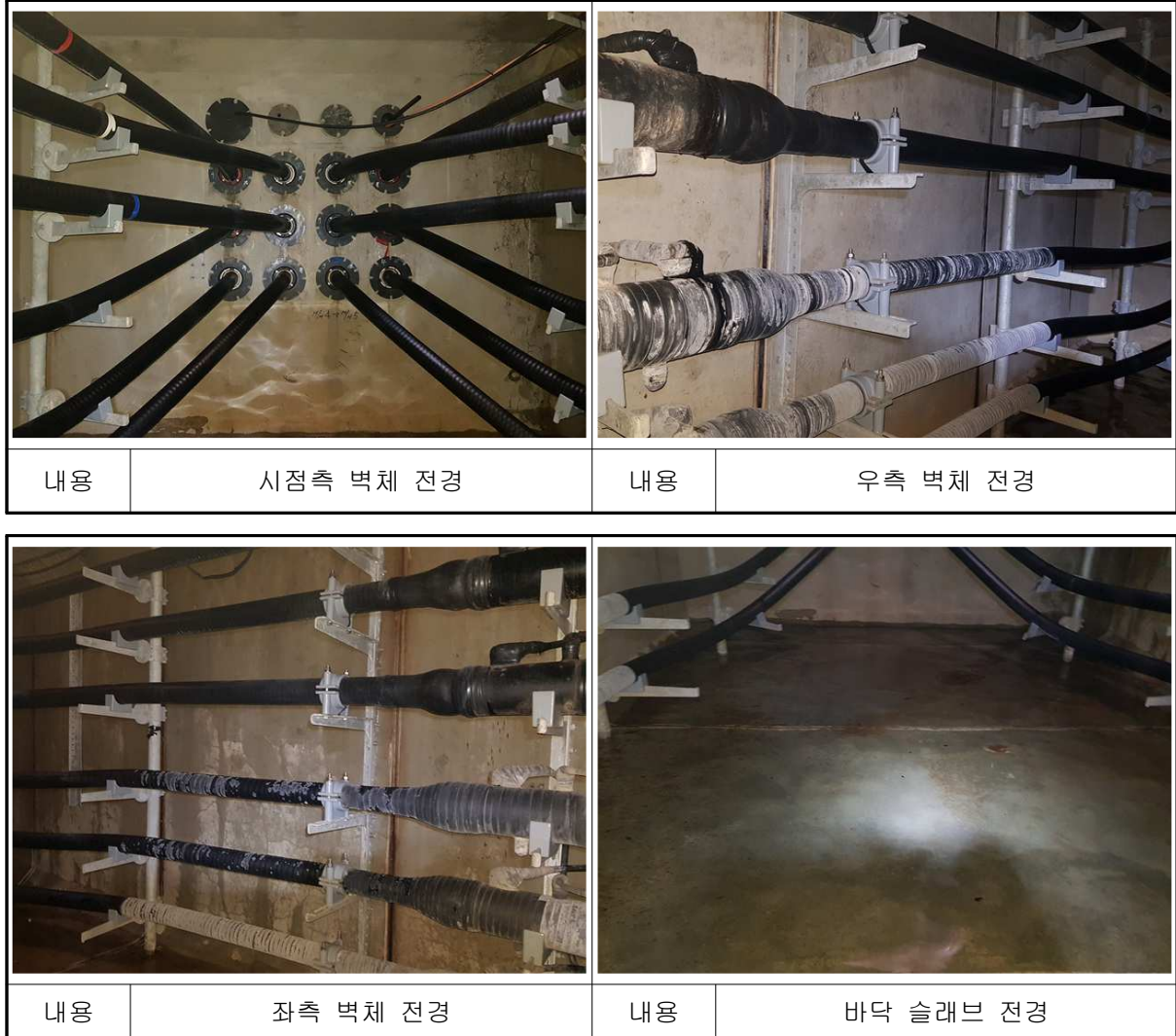
[사진 14.13] 일산~송포#4 전경
