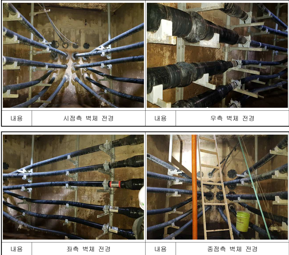
[사진 14.33] 일산~송포#9 전경
