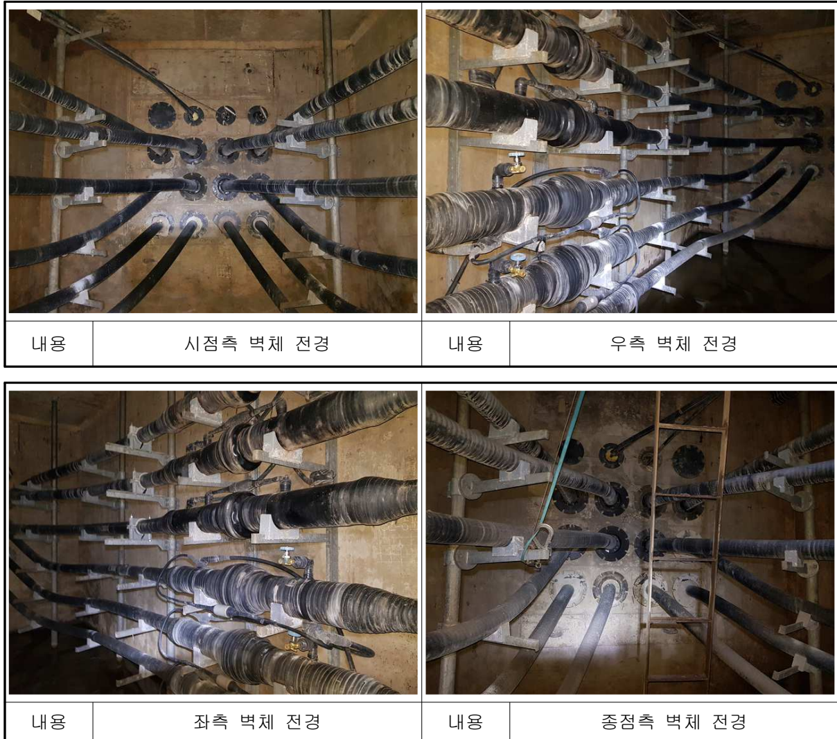
[사진 14.41] 일산~ 송포#11 전경
