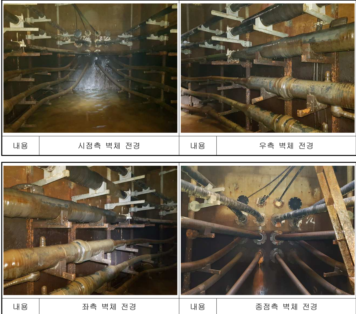
[사진 14.21] 일산~송포#6 전경
